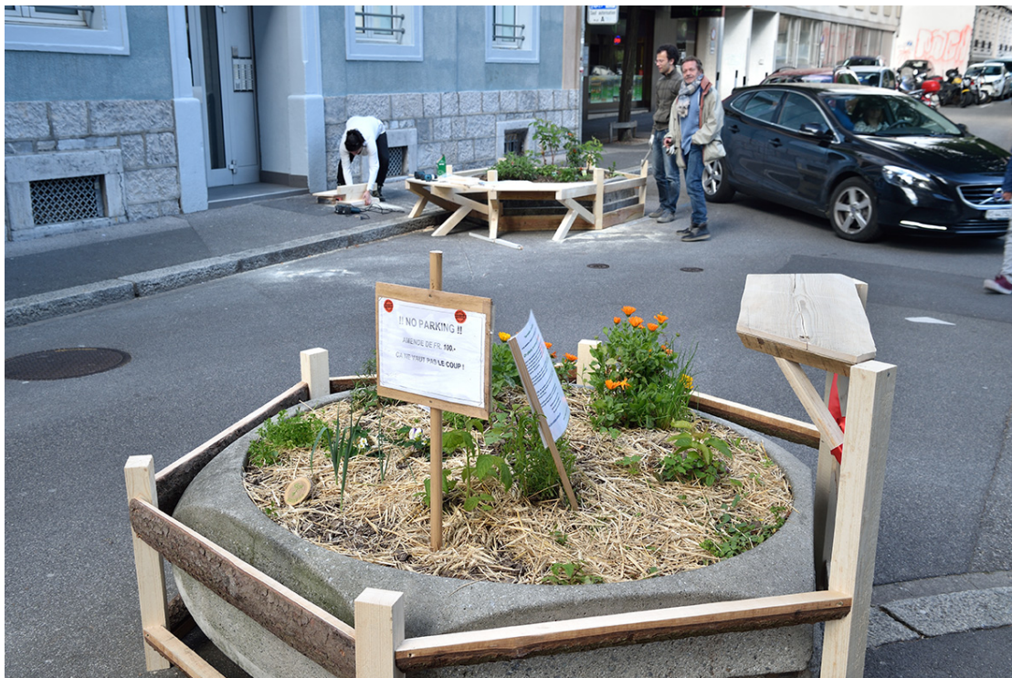
Vue d'une tablette et d'un banc en construction
