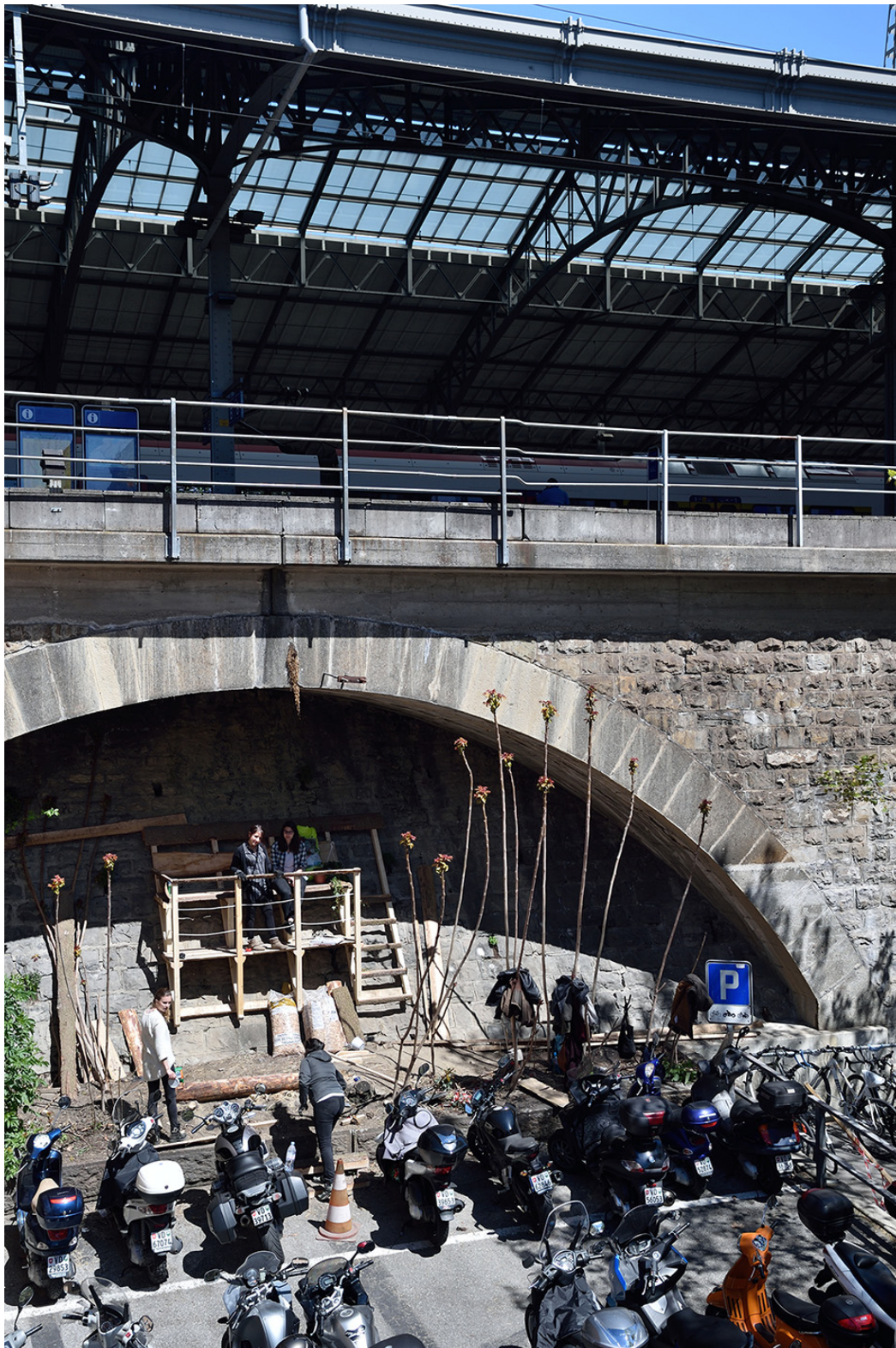
Le gradin, situé sous les voies de train
