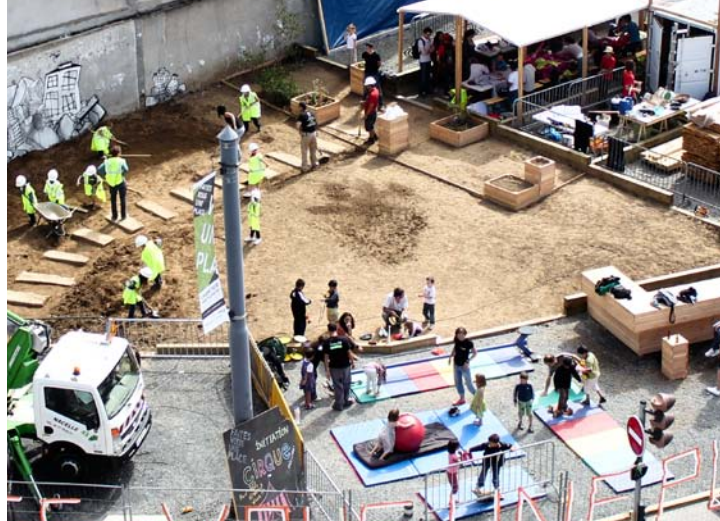
Construction et Chantier ouvert
