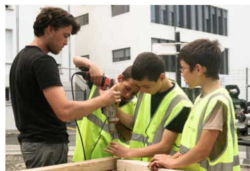
Atelier ouvert de construction
