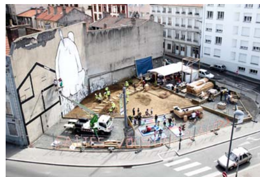
Juillet 2011: 1er chantier ouvert pour transformer la friche en espace public
